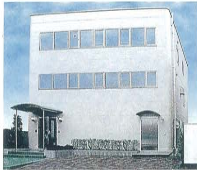
環境科学技術センター建物(さいたま市)
