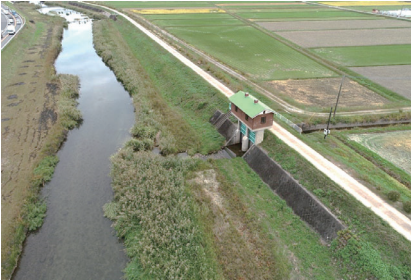
ドローンによる現地調査(金生地区)
