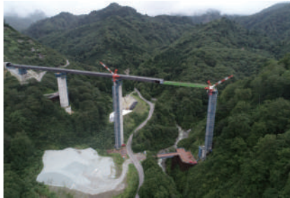
事業地のドローン空撮の様子
