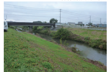
目久尻川の現況河道状況
