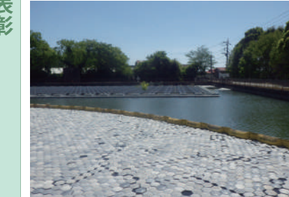
六角フロート(遮光板)によるアオコ対策の様子
