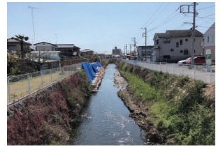
事業計画区間の森戸川(改修前)
