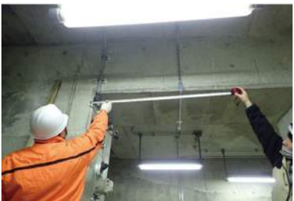
施設のひび割れ調査の様子
