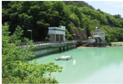
放流設備(予備ゲート)
