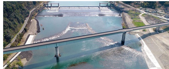
完成した八の字堰
