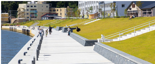
完成した堤防空間
