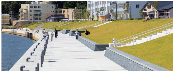
完成した堤防空間
