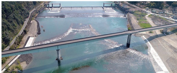
完成した八の字堰
